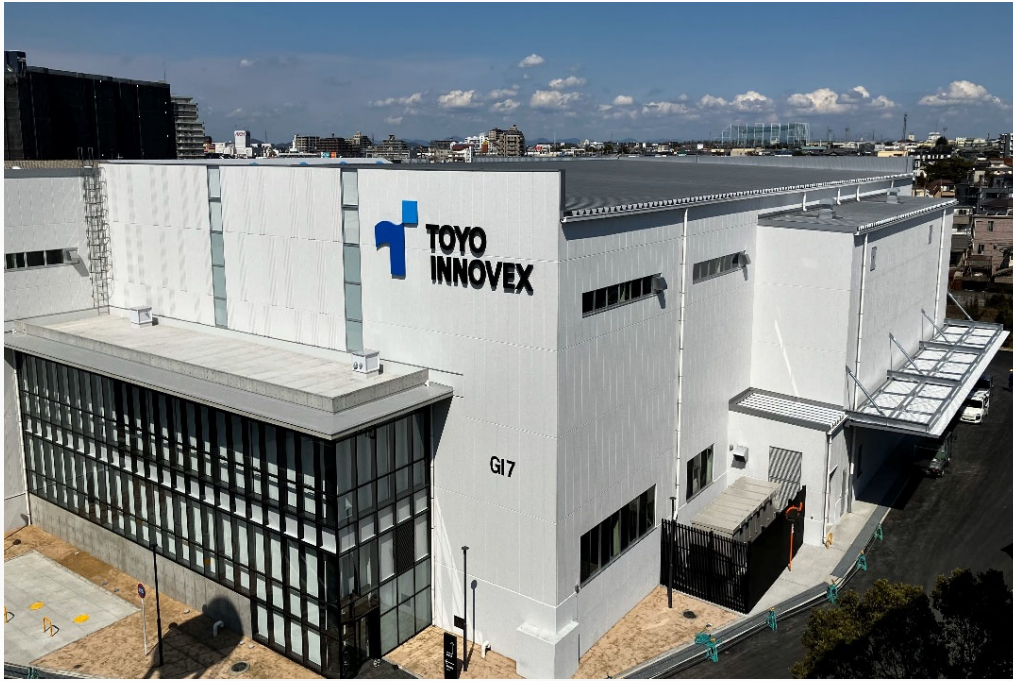
中・大型機組立工場外観（延床面積2,636㎡）
