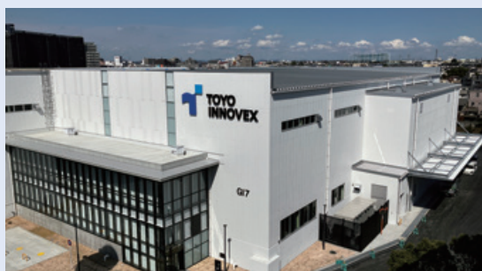
中・大型機組立工場外観(延床面積2,636㎡)
